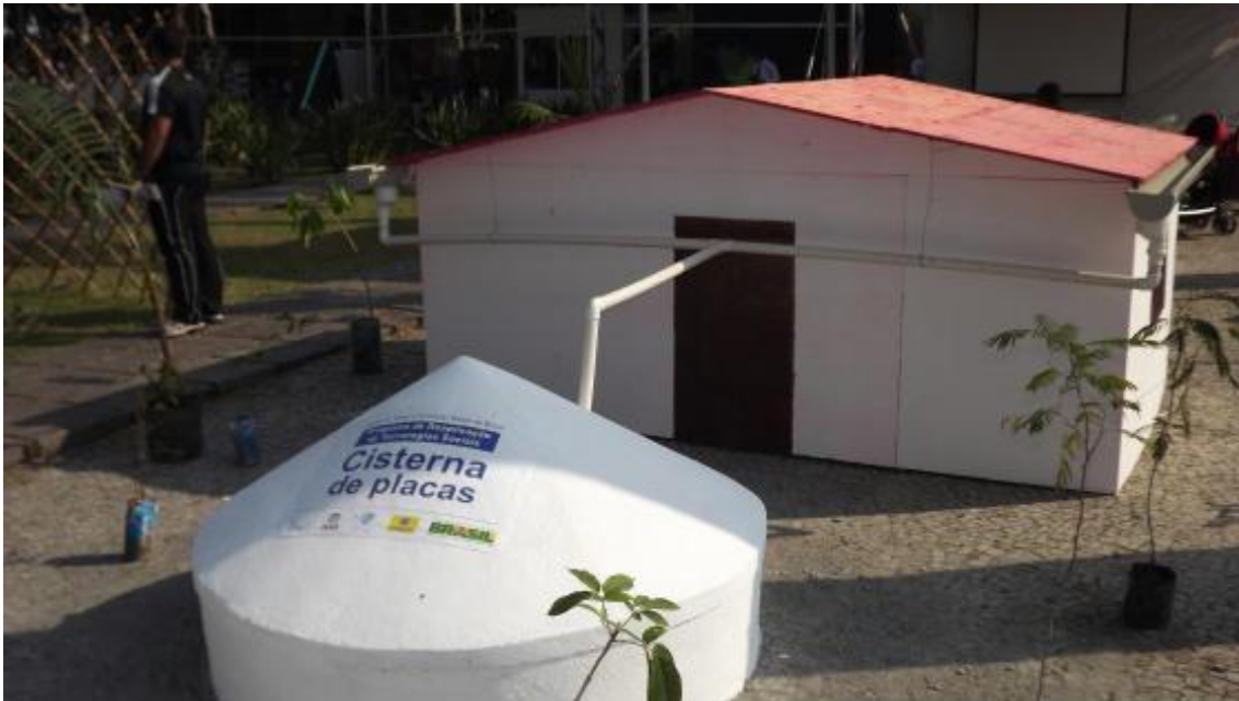
Figura 3: Estrutura da cisterna de placas de cimento, acoplada ao telhado de uma casa. Fonte: www.ecodebate.com
