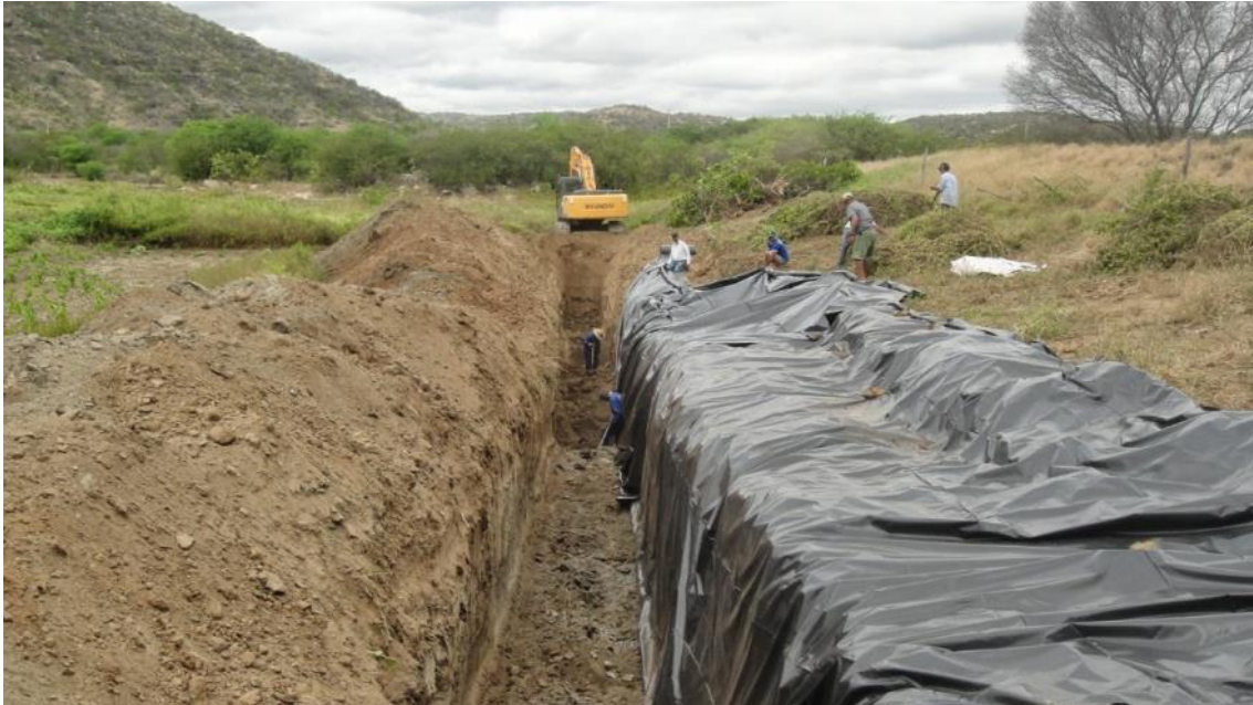
Figura 4: Construção de uma barragem subterrânea. Fonte: www.deolhonocariri.com.br
