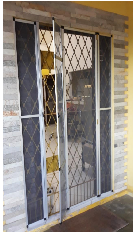
Figura 10 – Tela para porta com grade – acesso para cadeados
