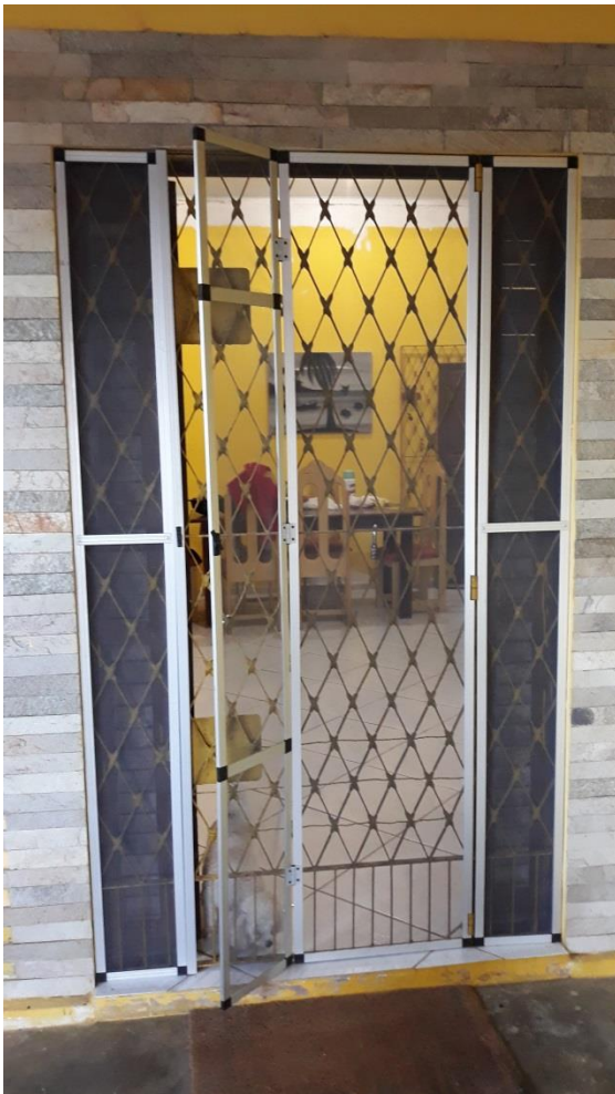
Figura 9 – Tela em perfil de alumínio para porta com grade
