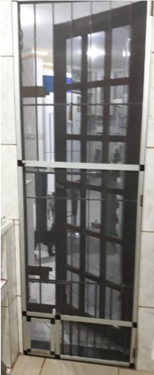
Figura 6 – Tela para porta confeccionada em perfil de alumínio
