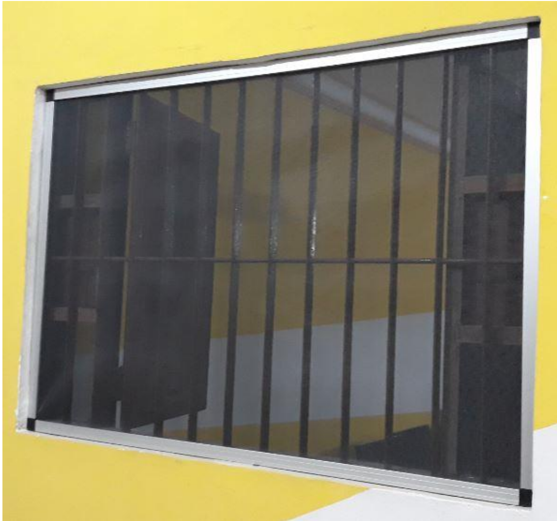
Figura 5 – Tela confeccionada em perfil de alumínio e encaixada em janela
