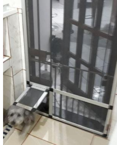
Figura 7 – Detalhe da passagem para animais (portinhola)
