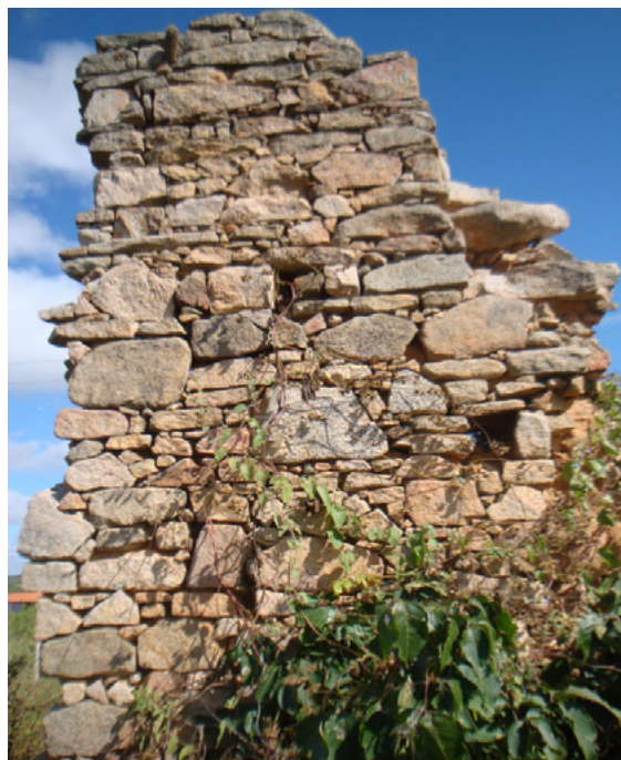
FIG. 2 – ANTIGA CASA DE PEDRA NO MUNICÍPIO DE SÃO VICENTE DO SERIDÓ.
