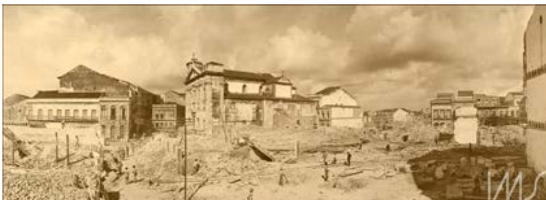
IMAGEM 01: DEMOLIÇÃO DO CASARIO E DA IGREJA DO CORPO SANTO, AO CENTRO, PARA REFORMA URBANÍSTICA DO BAIRRO DO RECIFE.
