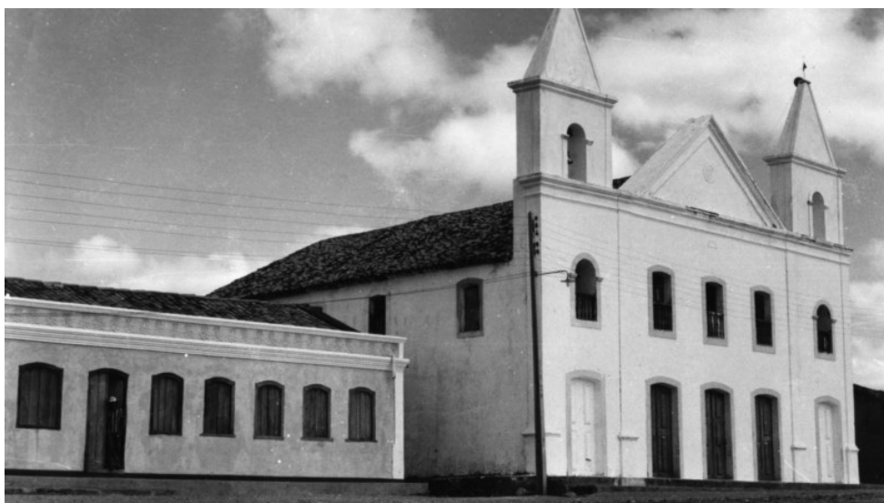
FIGURA 4: ANTIGA IGREJA DE SANTO ANTÔNIO EM PILÃO ARCADO
