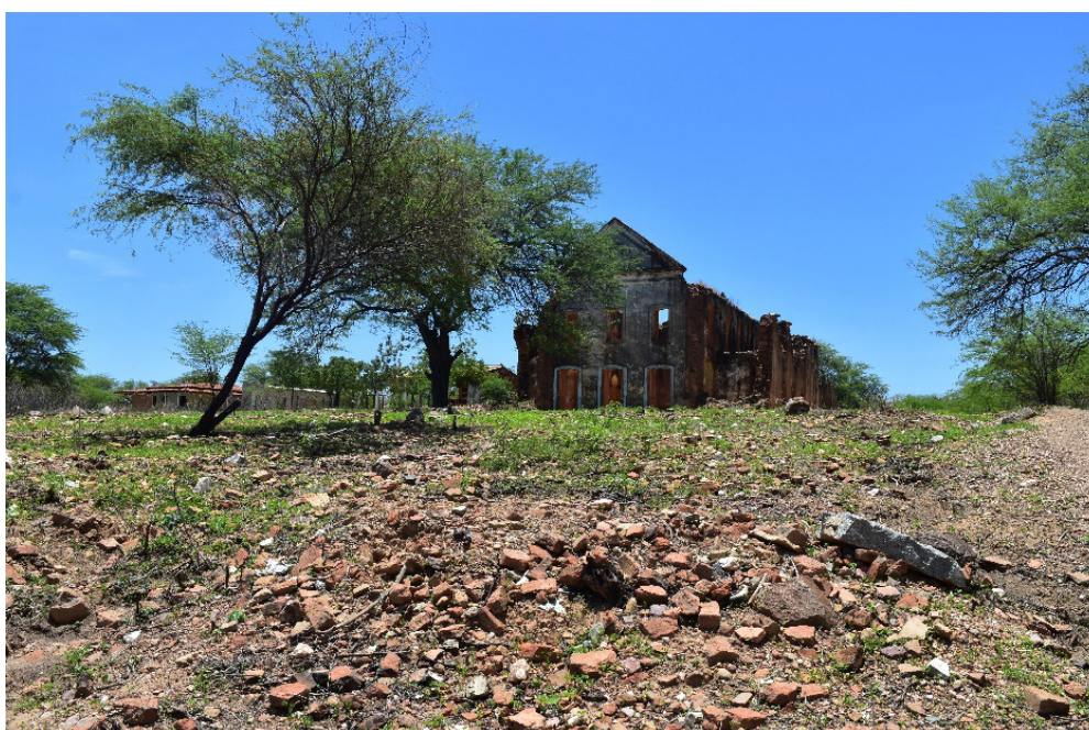
FIGURA 1: VISTA FRONTAL DA RUÍNA DA ANTIGA IGREJA SANTO ANTÔNIO NA “VELHA” CIDADE DE PILÃO ARCADE
