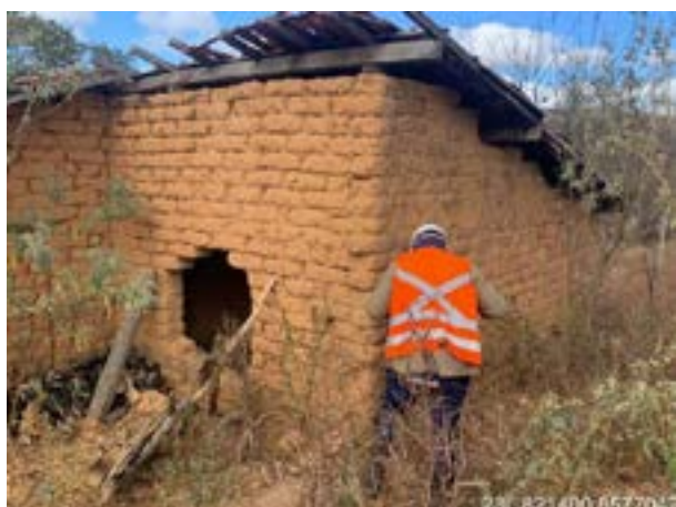
Figura 4: Caminhamento no sítio Alambique. Coordenadas: 23 L E= 821400m/N= 8577042m.
