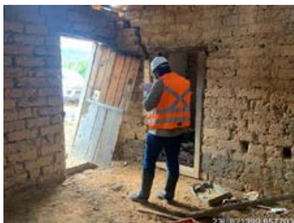
Figura 5: Caminhamento no sítio Alambique. Coordenadas: 23 L E= 821399m/N= 8577036m.
