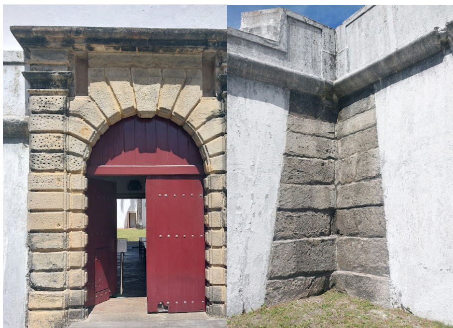
FIGURAS 2 E 3. CANTARIAS DE ARENITO NO ARCO DE ENTRADA E EM UM DOS CUNHAIS EXTREMOS DO FORTESÃO TIAGO DAS CINCO PONTAS.
